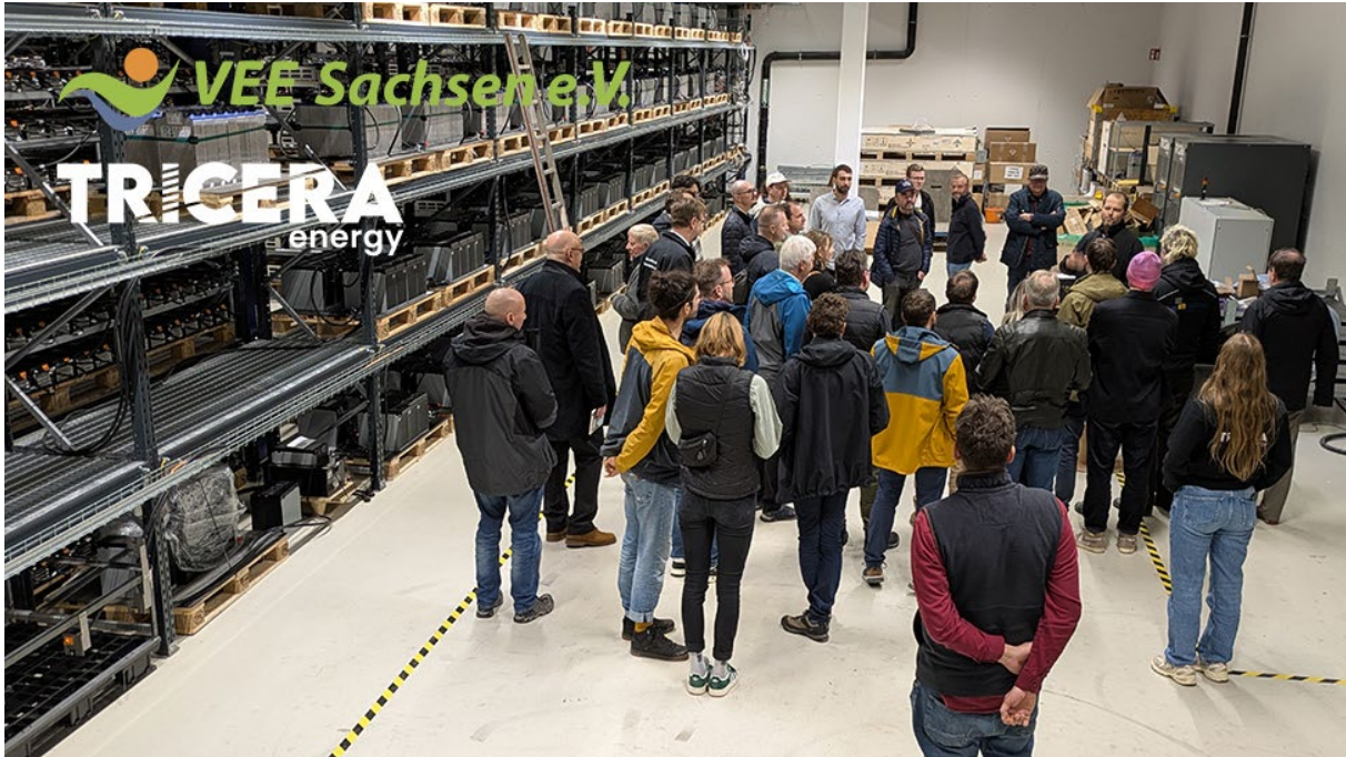
Bild während eines gemeinsamen Events in Sachsens größtem Batteriespeicher bei der JT Energy in Freiberg
