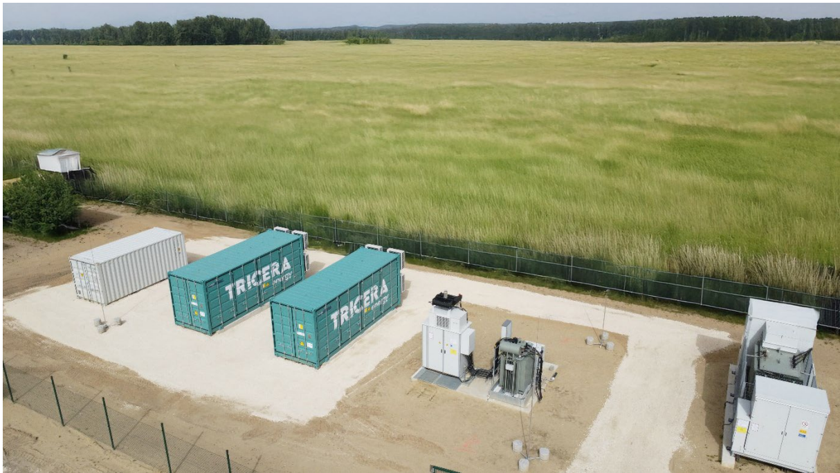
Bild: Symbolbild eines TRICERA-Batteriespeicher, wie er für die Stadtwerke Ulm/Neu-Ulm gebaut wird
