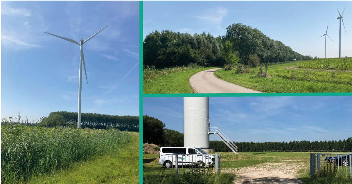
Bild: Vor-Ort-Aufnahmen des Eurus-Windparks, dem Standort des TRICERA-Batteriespeichersystems
